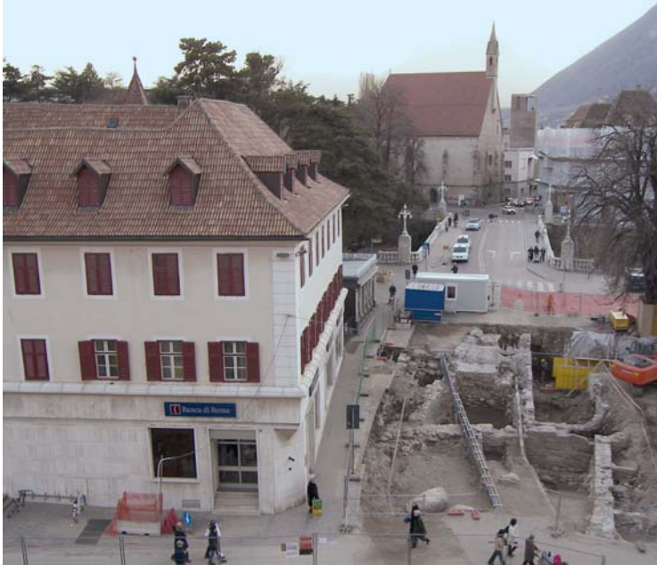
Fig. 1- Vista dello scavo da nord.
