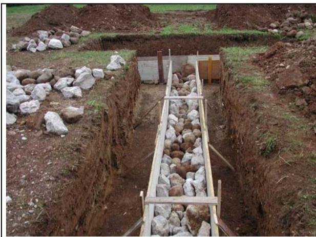
Fig. 5 – Muro a secco, fase di riempimento
