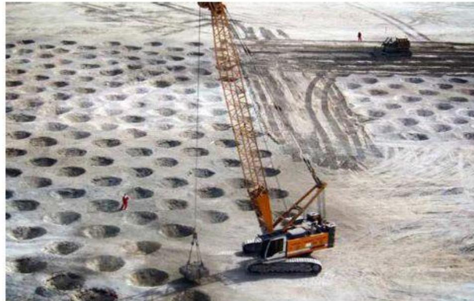
Gli interventi di compattazione del piano della discarica prevedono la realizzazione di un campo prova sperimentale per definire i parametri che verranno utilizzati durante la fase operativa. Nel campo prova sono state individuate 4 celle sperimentali
