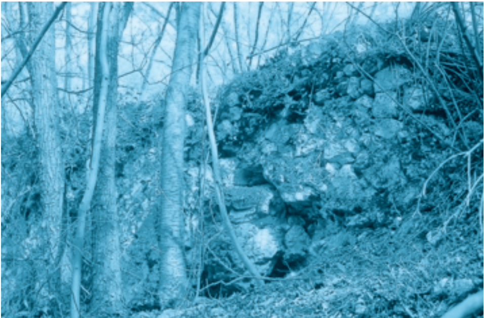
Fig. 21 - Tratto di struttura muraria posizionato sul fianco N dell'isola
