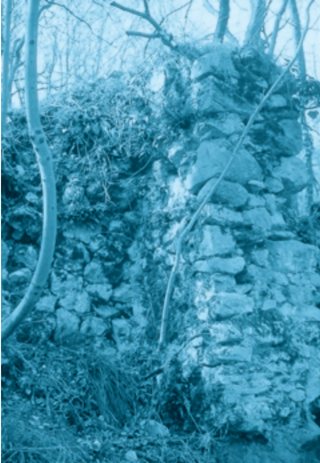
Fig. 9 - Tratto di struttura muraria con contrafforti situata sul fianco N-E dell'isola.
