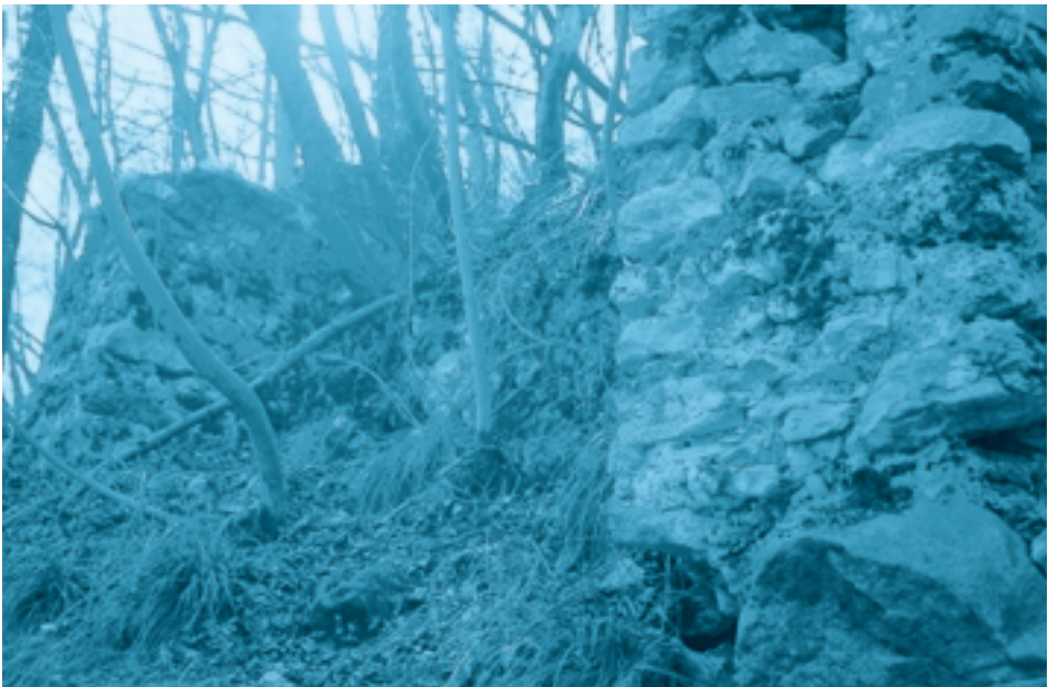
Fig. 8 - Tratto di struttura muraria con contrafforti situata sul fianco N-E dell'isola.
