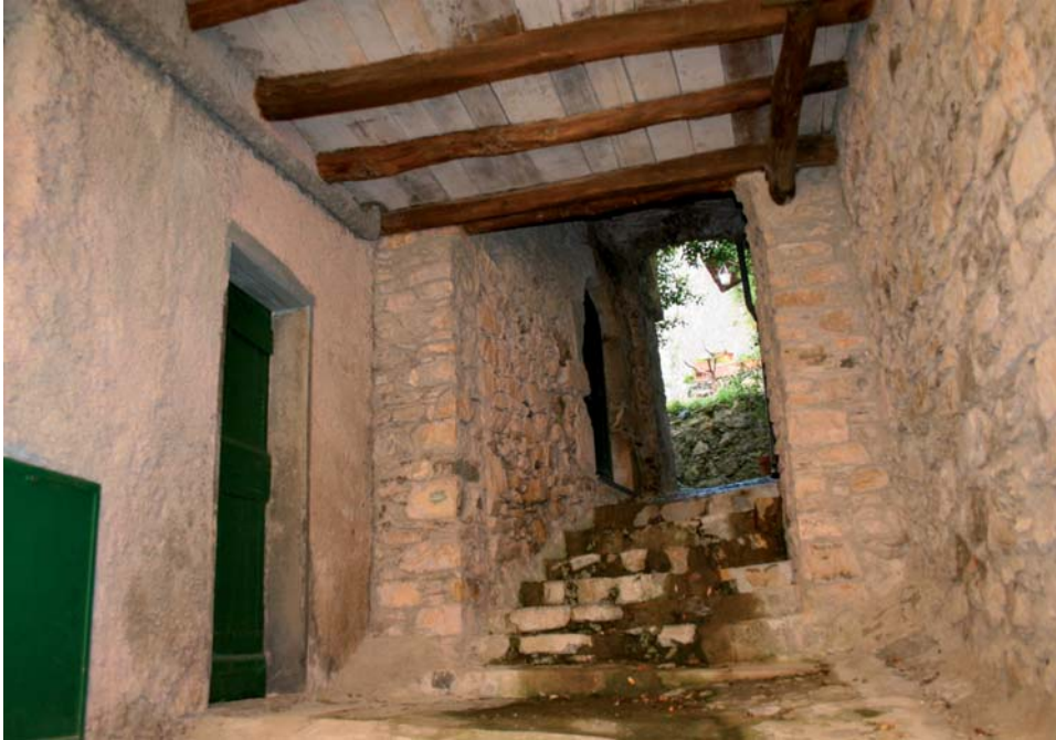
Fig. 1 - Velva. Primo solaio risalente al terzo quarto del XVII sec. con le travi PET-74 (ultimo anello misurato corrispondente all'anno 1665) e PET-75 (ultimo anello misurato corrispondente all'anno 1667). Il solaio è direttamente esposto sul carruggio sottostante.
