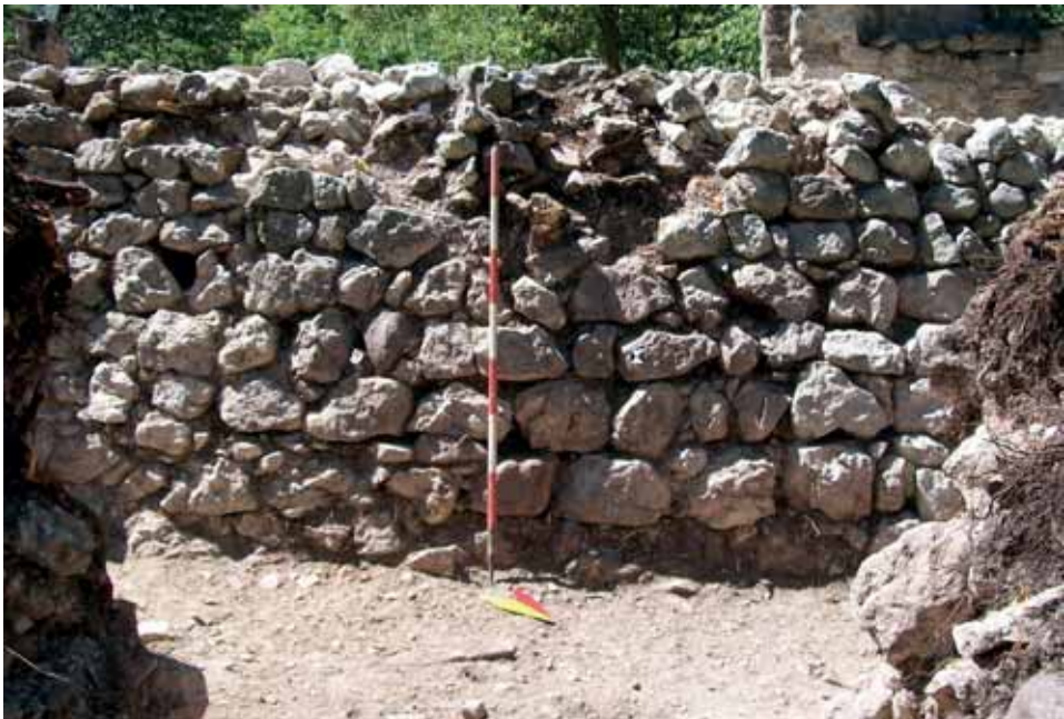
Fig. 26 - Settore C, prospetto della scarpa di rinforzo del perimetrale nord-est della chiesa.
