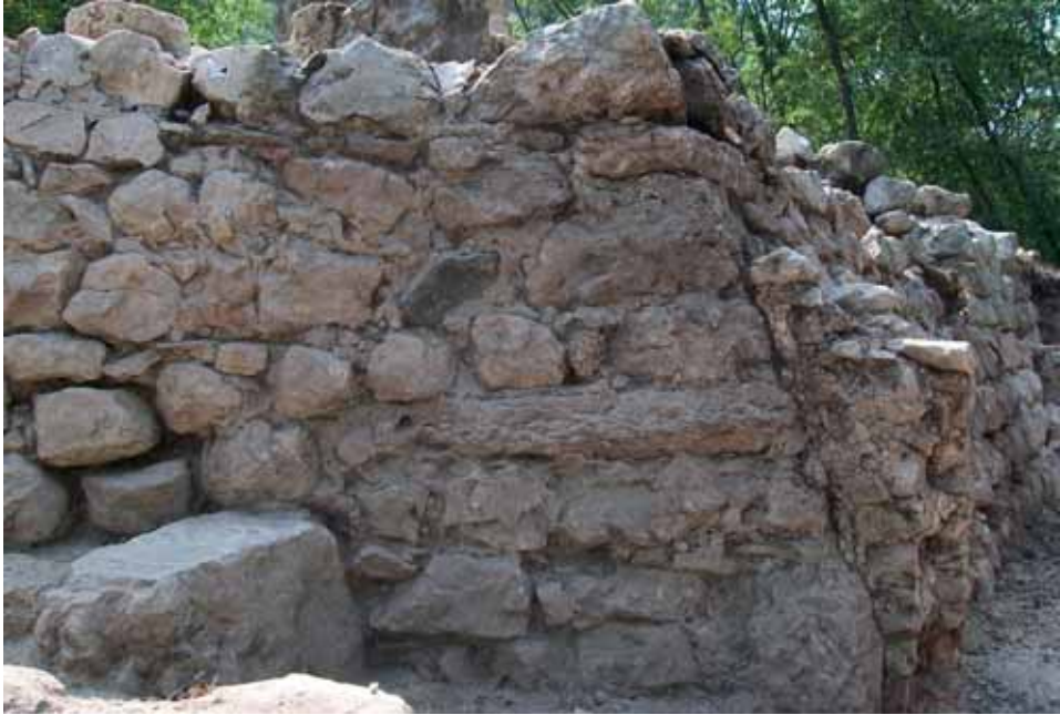
Fig. 25 - Settore C, pilastrino addossato alla scarpa di rinforzo del perimetrale nord-est della chiesa.
