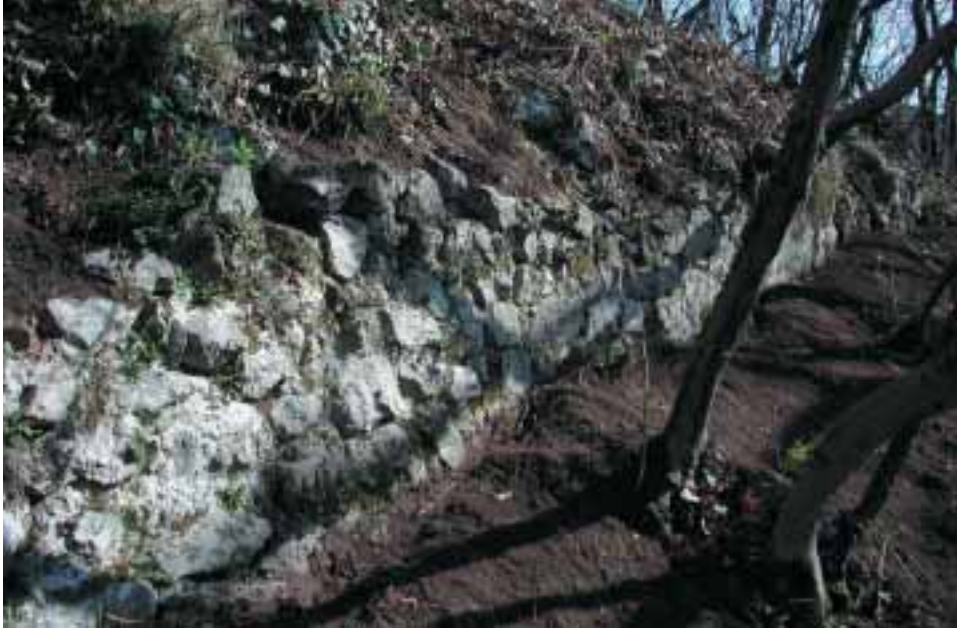
Fig. 1 - Tratto murario lungo il versante sud-occidentale dell'isola.
