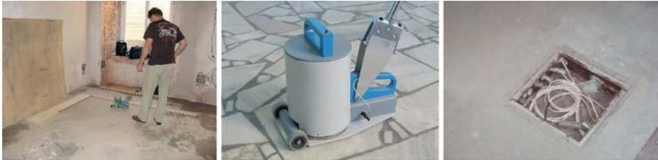
Fig. 11 - Operazioni di scansione manuale con radar olografico a 2GHz (sinistra e centro), pozzetti di derivazione (destra).
